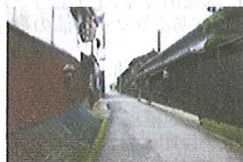
重要伝統的建造物保存地区写真
