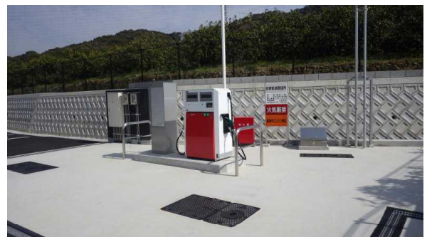
自家給油取扱所
