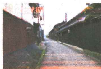
重要伝統的建造物保存地区写真
